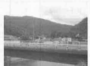
④ 崩落した橋
