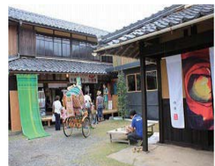
民宿をカフェとして改修
