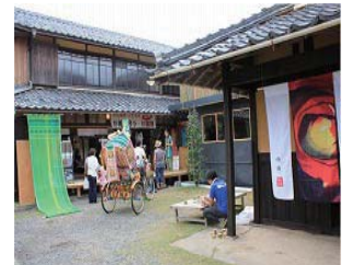
民宿をカフェとして改修
