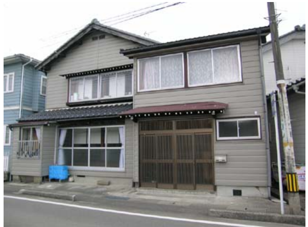
写真 4.1-9 僅かな被害家屋の下屋 (穴水地区)
