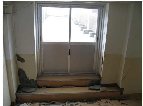
(c)階段室部分の損傷
