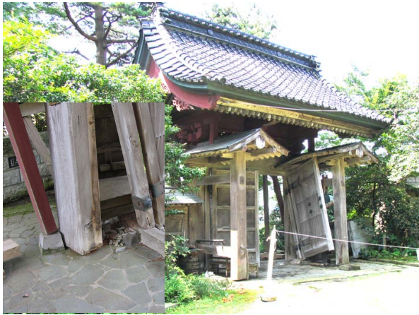
写真 6. 2-4, 5 宝蔵寺山門の被害
