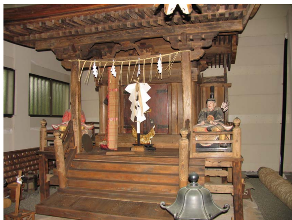
写真 6. 3-12 多多神社本殿の被害
