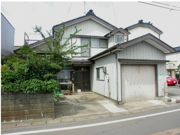
写真 4.4-2 柏崎市内の住宅 新しくはないが、ほとんど被害が見られなかった。
