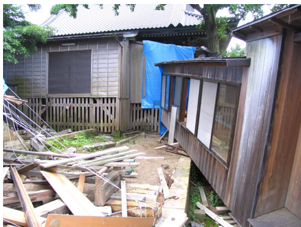
写真 6.3-1, 2 柏崎神社本殿等の被害
