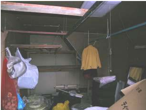
写真 4.1-6 C/B基礎増築部の階段半落下 (穴水地区)
