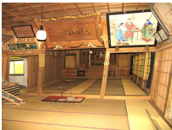
写真 6. 3-8, 9 香取神社社殿の被害
