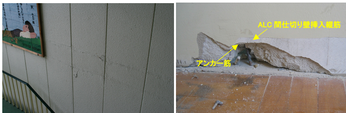
写真 3.4-3 階段室 ALC 板のひび割れ
