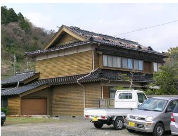
写真 4.1-2 非倒壊家屋の屋根瓦 (鹿磯地区)
