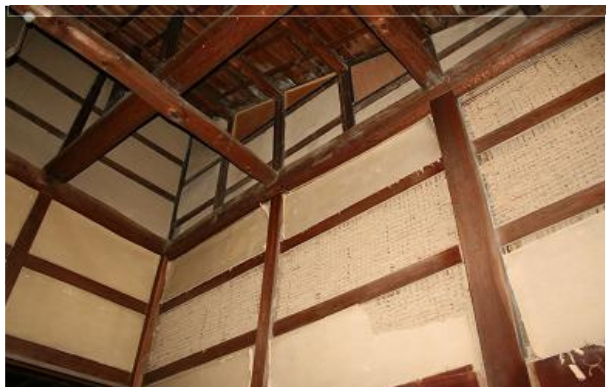
写真 4.5-3 同じ住宅内部、柱、壁などの損壊状況
