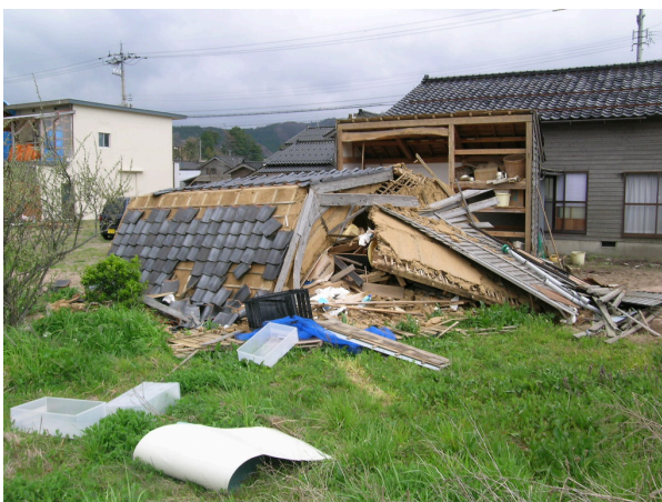
写真 5.4 土居葺きを省いた瓦葺き。化粧野地の上に直接瓦棧が埋め込んである。
