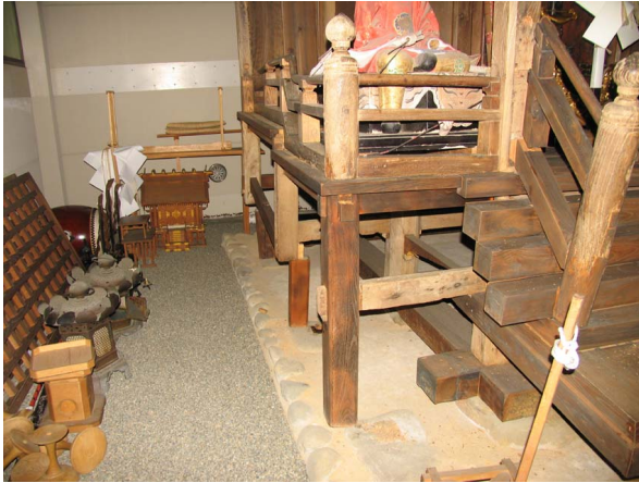
写真 6.3-13 多多神社本殿縁束の被害
