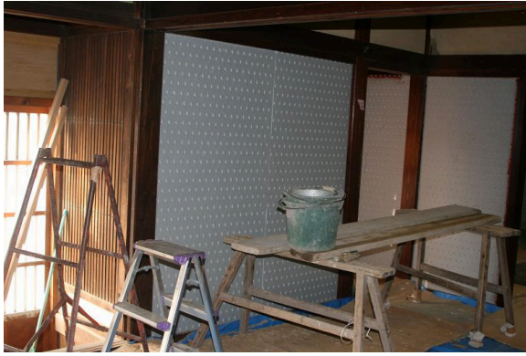
写真 7.5-5 筋かいとボード張りの増設壁
