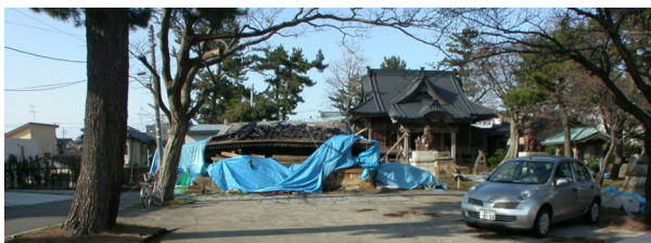
写真 7.3-6 修復が進んでいない様子の柏崎神社
