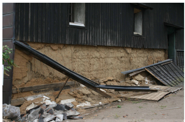
写真 5.3-1 縄列の面で壁土が剥離崩落した腰壁。
