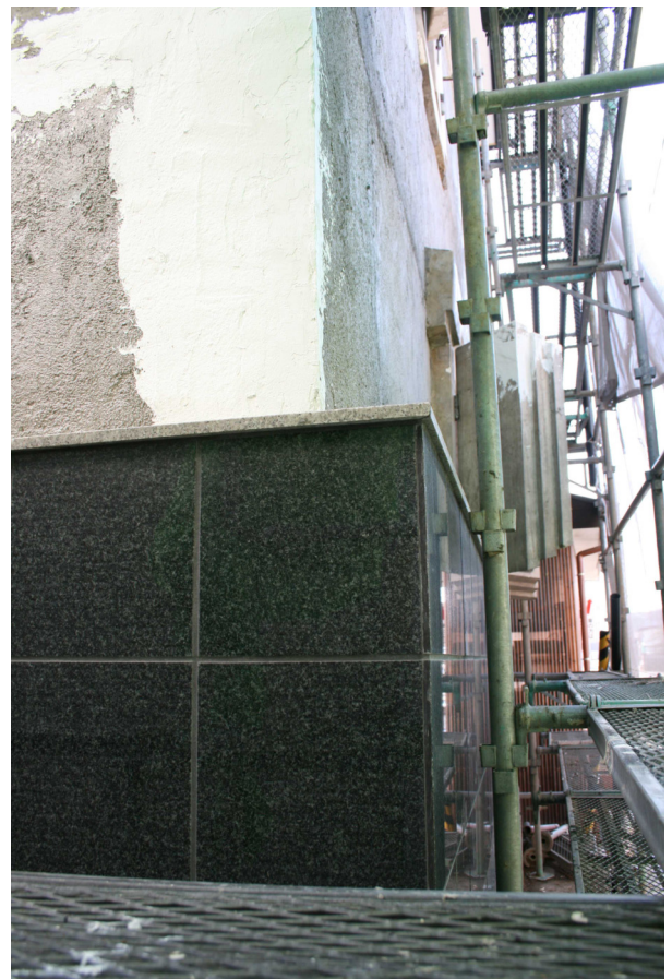
写真 7.4-2 モルタルと石張りによる土蔵の修復(東本町)
