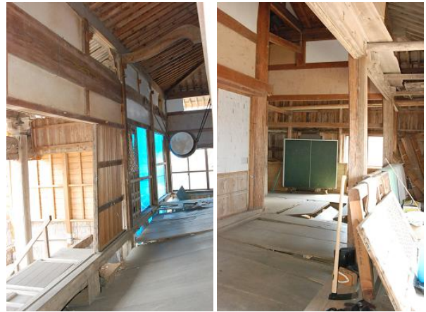
写真 6.2-3~5 福善寺本堂の被害状況
