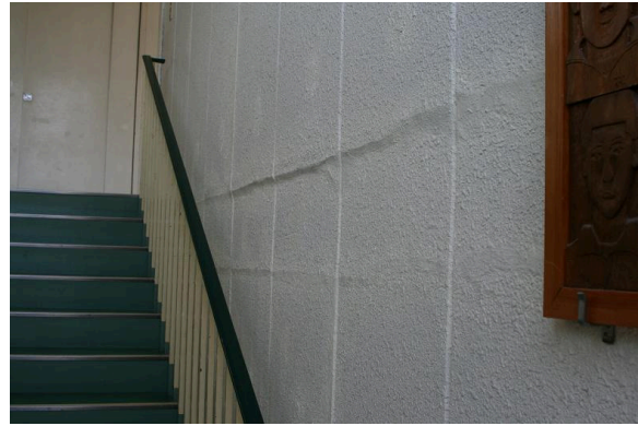
写真 7.2-1 目地ずれした内部階段室 ALC 板の復旧
