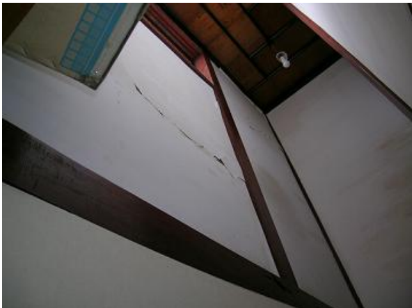
写真 4.1-7 既存住宅の壁のひびわれ(穴水地区)
