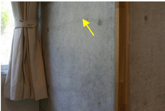
写真 7.3-5 SRC 柱に新たに発生したひび割れ
