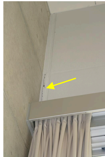
写真 7.3-2 放置されている損傷した構造スリットの建物内部側
