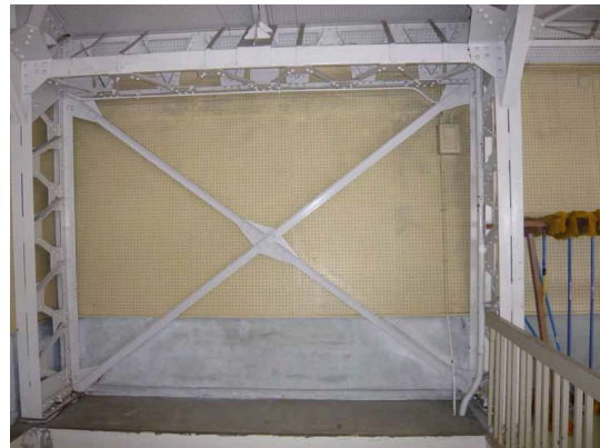
写真 7.4-1 階段側 X 形筋かいの取替え補修状況
