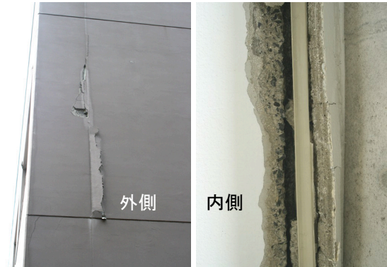
写真 3.3-2 構面内壁端部のスリットの損傷
