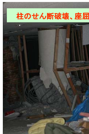
写真 2.1-3 1階部分の倒壊(東本町の商業建築)
