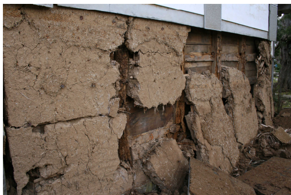
写真 5. 3-1 腰のモルタルがメタルラスともども崩落した。上部もモルタル仕上だが辛うじて崩落を免れた。柱は既に腐朽していた。
