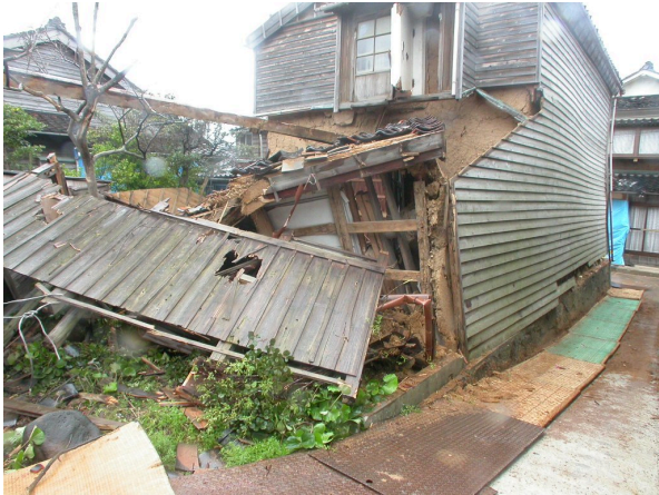
写真 4.2-4 下屋（戸前）が崩壊した土蔵（黒島）
