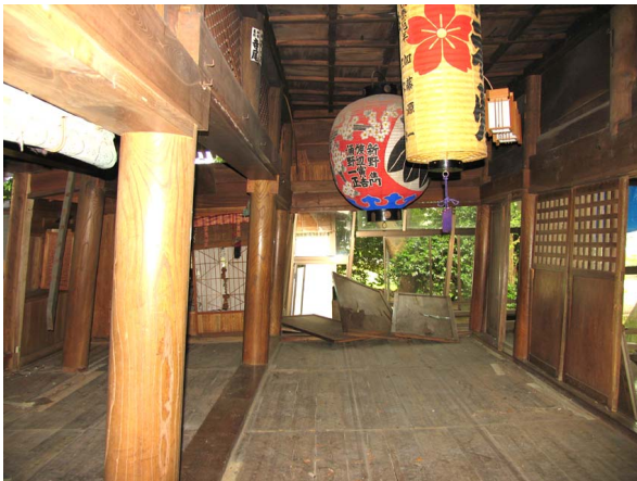
写真 6.3-14 多多神社拝殿の被害
