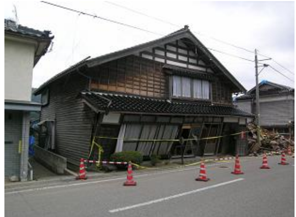
写真 4.1-8 被害を大きくした下屋 (道下地区)
