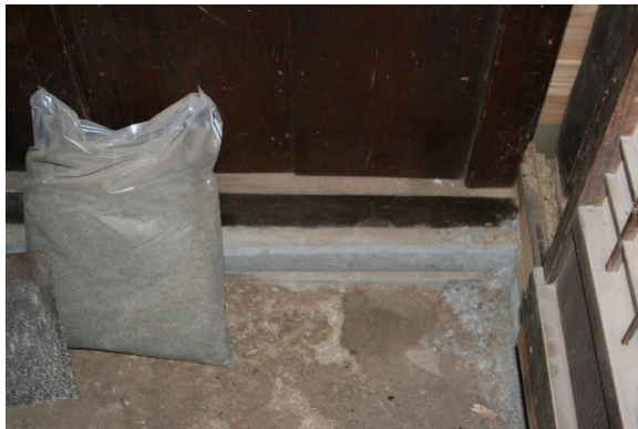
写真 7.5-6 モルタルで塗り固めた土台
