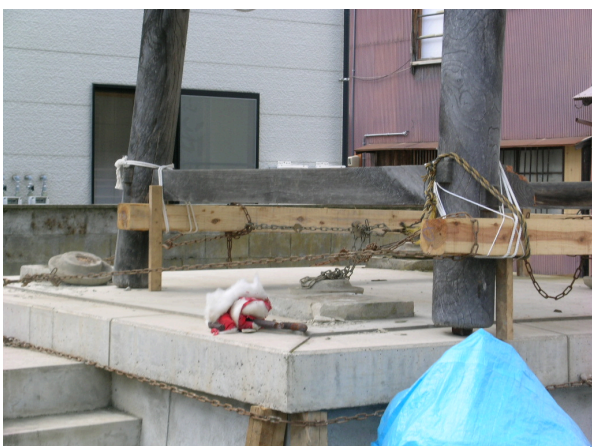
写真 6.3-1,2 法性寺鐘楼の被害
