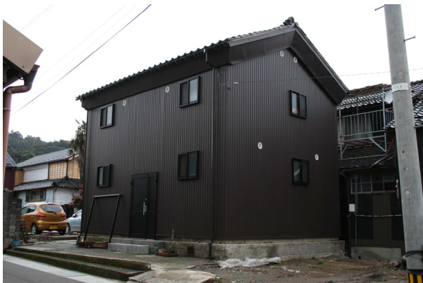
写真 7.6-2 全体を金属板で覆って修復した土蔵
