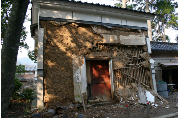
写真 7.6-1 修復に着手していない土蔵
