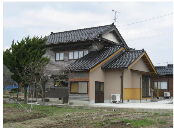
写真 7.5-8 住宅一部を取り壊して修復した例
