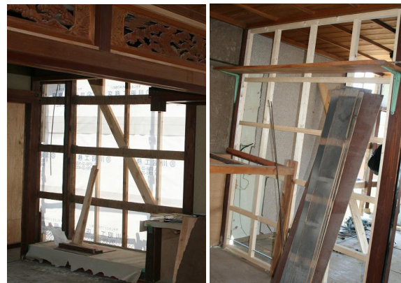
写真 7.5-3 桁面外壁の補修・補強(左)と張間方向の内部耐力壁の増設(右)
