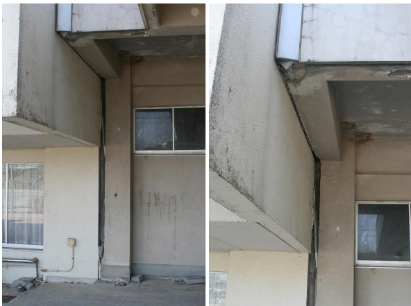
写真 7.1-1 Exp.j の損傷がそのまま放置されている状態 (輪島市立鳳至小学校)
