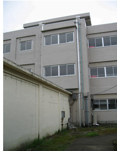
(a)階段室部分外観
