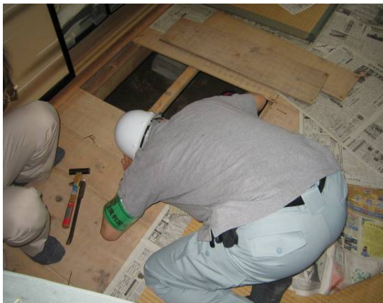
写真 1.4-3 床下の調査の様子 (地盤が液状化現象を起こしていて床が傾斜している)
