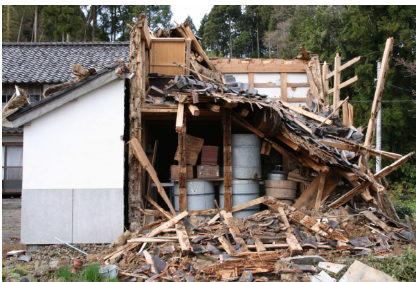
写真 5. 1 貫間隔が狭く、柱の外側が腐朽したために柱が割れたしまった農家の土蔵。外部仕上はモルタルである。
