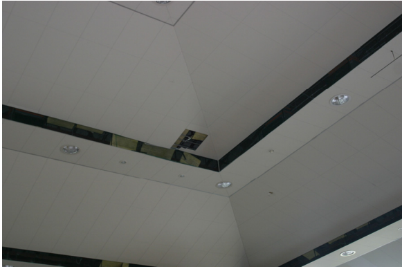
写真 3.1-1 パネル落下(西山総合体育館)
