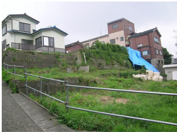
写真 4.1-1 西本町北部の斜面建物の被害
