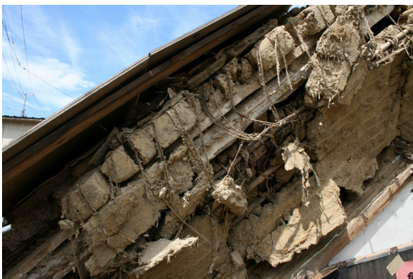
写真 5.2-1 ケラバに並べた日干し煉瓦。上のコンパネは後世の修理によるもの。屋根土の上下に漆喰の層が認められた。
