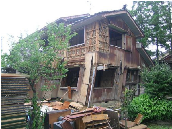
写真 4.4-1 下屋のない方向に傾斜した住宅 (柏崎市 中田)
