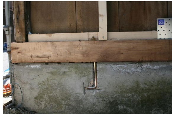
写真 7.5-4 取替えた土台とアンカーボルトの新設
