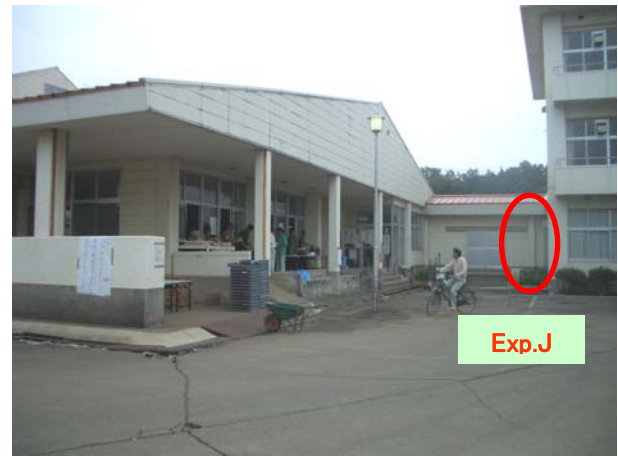
写真 2.1-1 日吉小学校渡り廊下全景
