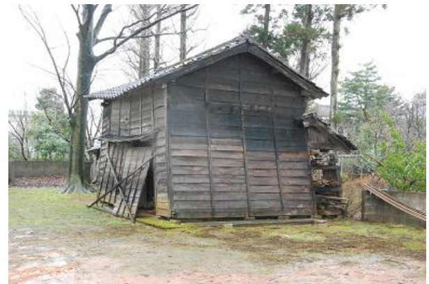
写真 7.3-2 修復を待つ日吉神社の倉庫(柏崎市中田)
