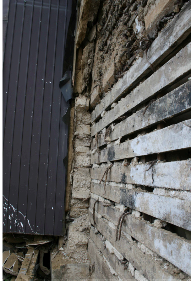
写真 5.4-1 機刷りの外に日干し煉瓦を積む。
