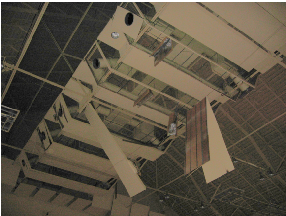
写真 3.1-3 空調ダクトを覆うパネルの落下 (西山中学校体育館)
