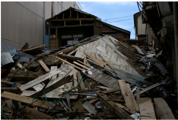
写真 5.1 野地板に塗った漆喰。右端にモルタルで固めた熨斗積が形を保ったまま見える。
