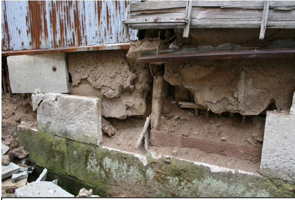
写真 5.3-2 腰壁を保護した石が崩壊した例。石を留める金物が不完全であるか、柱が腐朽して釘を保持できなくなっている。
