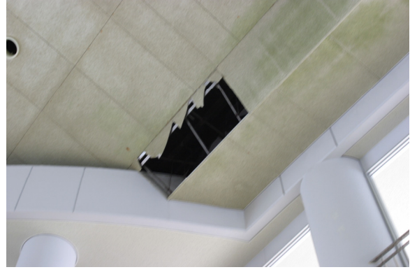
写真 3.1-2 パネル落下(柏崎アクアパーク)
