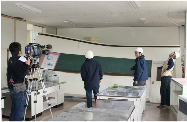
写真 3.4-5 完全に倒壊した間仕切壁
