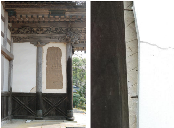
写真 6.2-1,2 総持寺法堂玄関壁の剥離状態。
