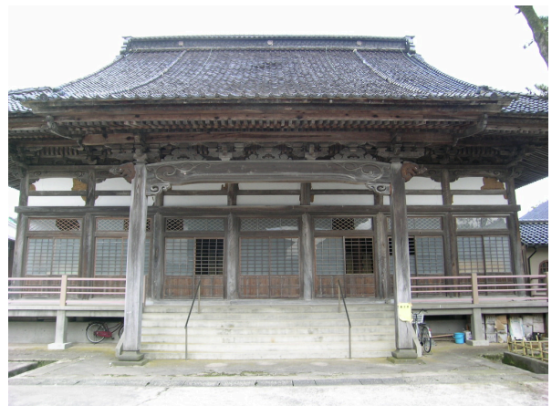
写真 6.2-7 軽微な被害の法性寺本堂
