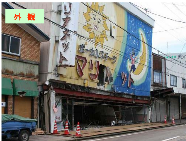
写真 2.1-3 1階部分の倒壊(東本町の商業建築)
