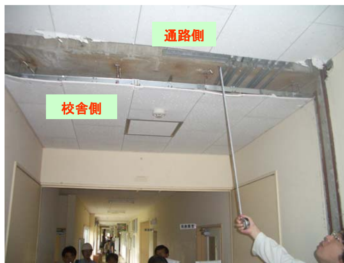
写真 2.1-2 Exp.Jの損傷の一例(日吉小学校)
