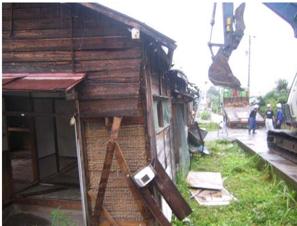
写真 1.2-1 判定訓練用被災モデル住宅の作成
