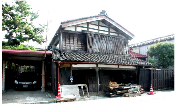
写真 4.5-1 隣接する鉄骨構造の車庫に寄りかかり、倒壊寸前の住宅 (柏崎市 市内)
