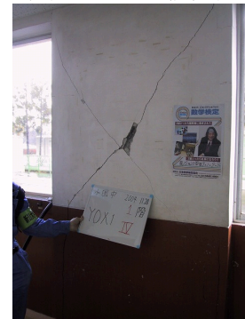
(b)2004年中越地震での被害(せん断ひび割れ)
