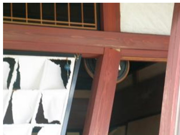
写真 4.1-4 柱の損壊事例2 (道下地区)
