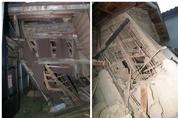
写真 4.7-2,3 同じ住宅の背後の状況 背後の土蔵が崩壊し、周囲の建物に被害を及ぼしている。
