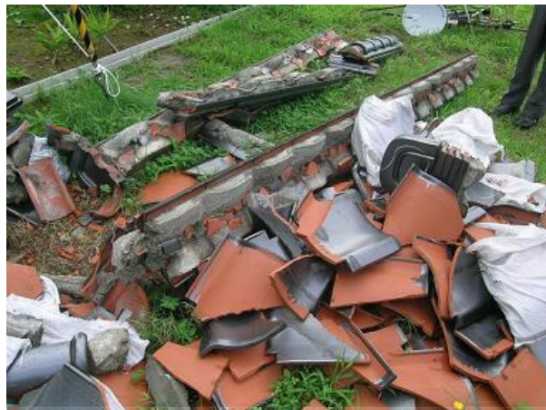
写真 4.2-1 落下した瓦(東の輪町) 棟がモルタルで一体化している。
