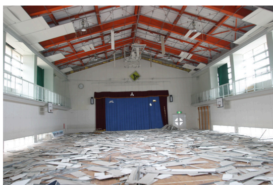
写真 3.2-2 天井パネルの大規模落下
