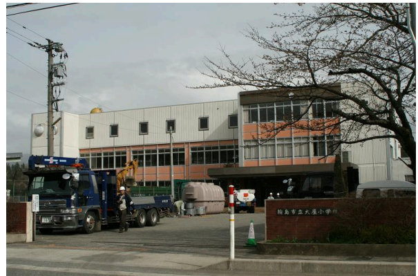
写真 22-2 大きな被害が生じなかった大屋小学校
