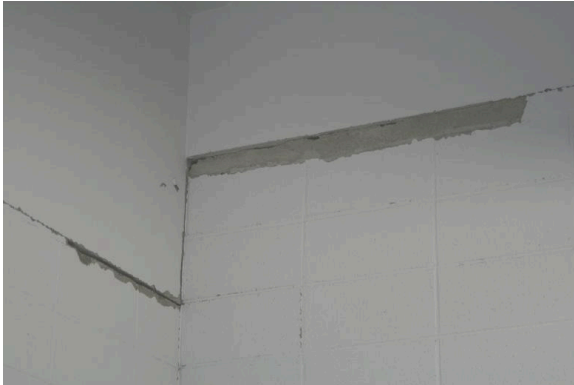
写真 7.3-4 放置されている CB 壁上部の目地の損傷部
