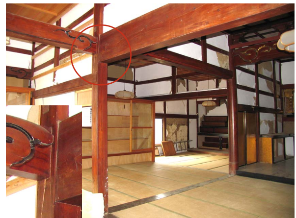
写真 6. 2-8, 9 明蔵寺本堂の被害
