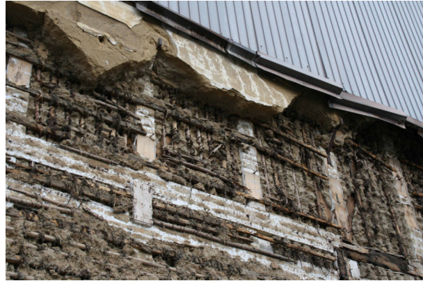
写真 5.4-2 柱に打たれた金物。縄が黒ずんでいる。
