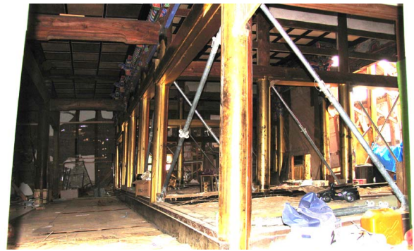
写真 6. 2-12, 13 西永寺本堂の被害
