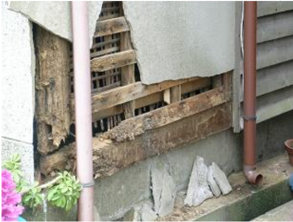
写真 4.1-5 柱下部・土台腐朽による損壊事例 (道下地区)
