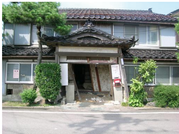
写真 4.3-2 石積基礎の住宅の被害(柏崎市新花町)
