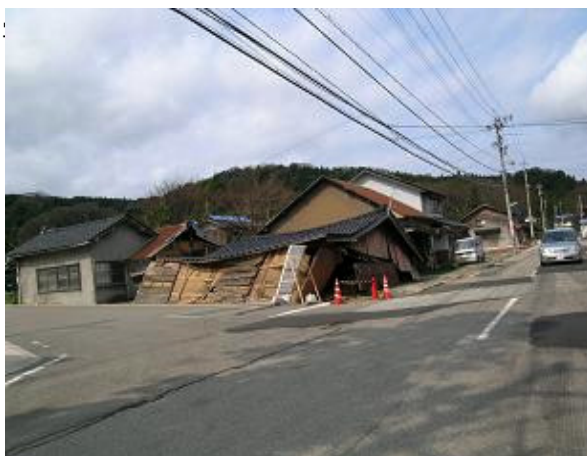
写真 4.1-1 倒壊家屋の屋根瓦 (門前地区)
