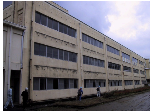
(a)2004年中越地震での被害(全景)
