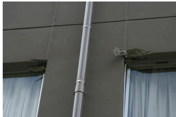
写真 3.3-3 垂れ壁部スリットの損傷
