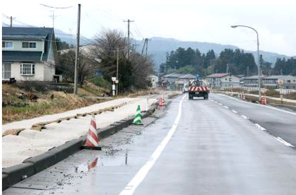
写真 7.1-1 復旧を待つ道路（柏崎市堀）
