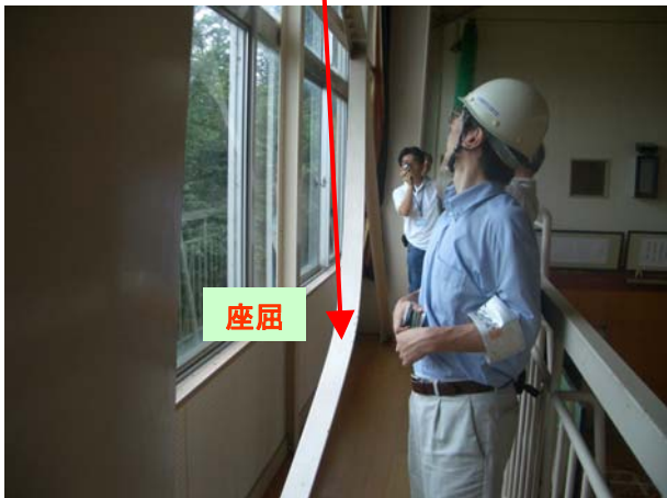
写真 2.2-1 軸組筋かい座屈(日吉小学校体育館)
