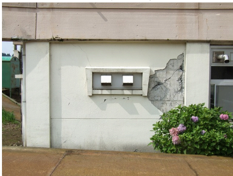
(b)有開口壁の損傷
