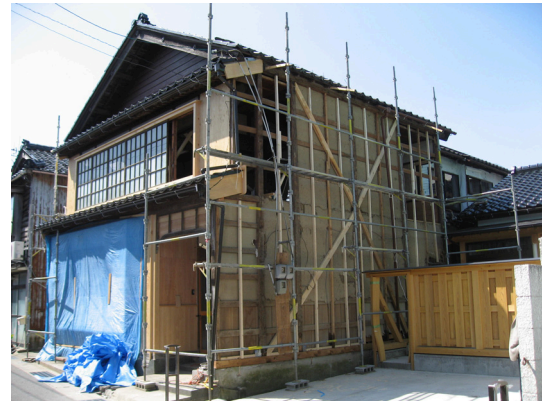
写真 7.5-2 古い一般住宅の修復工事例
