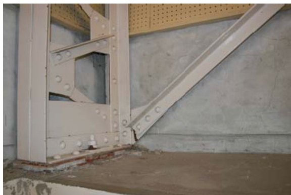
写真 2.1-1 柱脚と接合部の損傷
