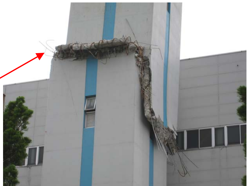
写真 2.1-4 煙突の被害(クリーンセンター)
