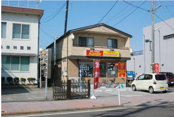
写真 7.2-3 新築された商店街の建物(東本町)
