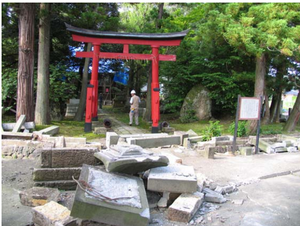
写真 6.3-15 多多神社鳥居等の被害
