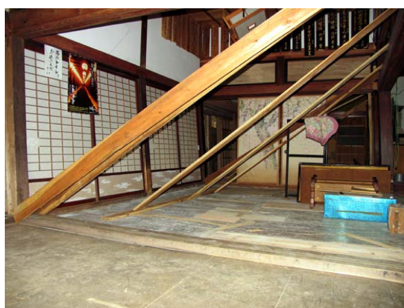
写真 6.2-1, 2, 3 大泉寺本堂の被害
