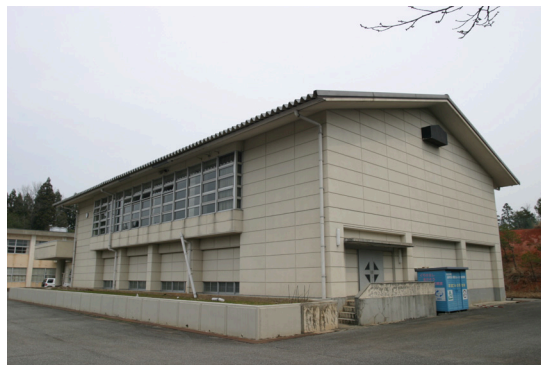
写真 3.2-1 神野小学校体育館の外観
