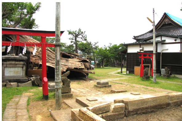
写真 6.3-3 石井神社社殿の被害
