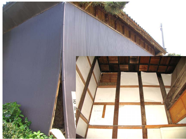
写真 6. 2-14, 15 閻魔堂の被害
