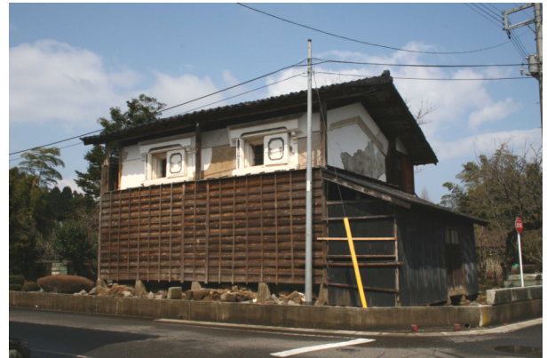
写真 7.4-1 壁が崩落した郊外の土蔵 腰板の内側は見かけ以上に被害を受けている様子が伺えるが、まったく手つかずである。
