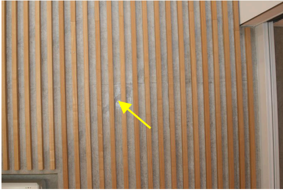
写真 7.3-3 見えるところだけパテ状のものを塗ったひび割れ
