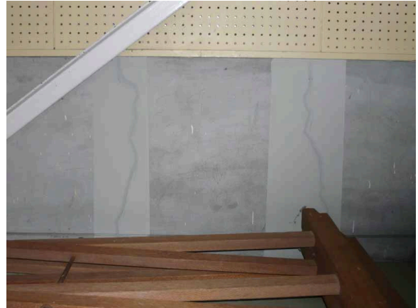
写真 7.4-5 RC 腰壁のひび割れ補修状況
