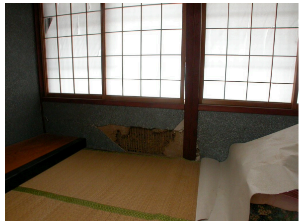
写真 4.2-3 門前地区の住宅内部の壁の損傷
