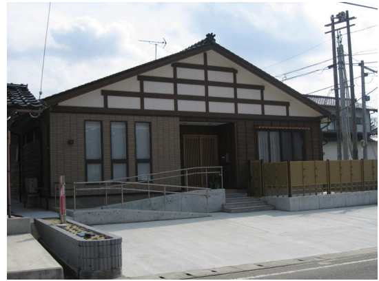
写真 7.5-7 平屋で新築の例
