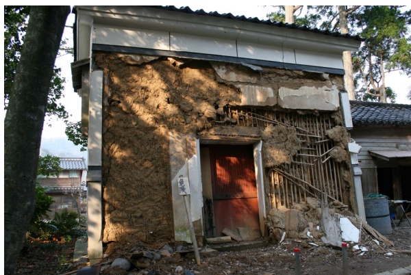
写真 5. 2-2 外壁がモルタル仕上になっていた寺院の土蔵。倒壊は免れたが壁が剥落した。標準的な結び下げを見て取ることができるが、柱外面は既に腐朽している。
