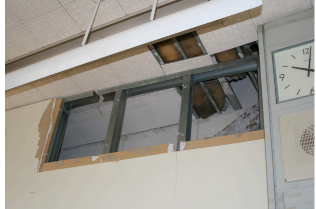
写真 3.4-6 ALC 板と筋かい構面の化粧壁
