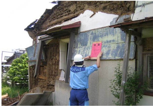
写真 1.4-4 H19.7.19 AM10:00～ 柏崎市中浜・大久保地区における判定作業
