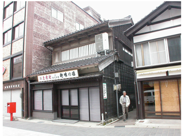
写真 4.2-5 鳳至地区に建つ商店 ほとんど被害が見られない。
