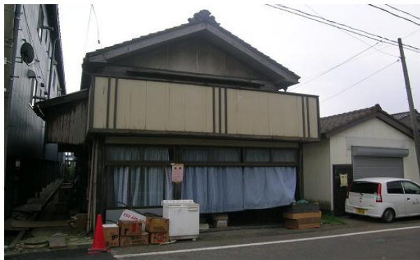
写真 4.7-1 この商店も間口が広く開いて柱や壁が少ないため、1階部分に若干の被害が見られる。
