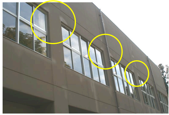
写真 7.3-1 損傷した外面の構造スリット
