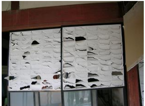
写真 4.1-10 障子紙の破損事例 (道下地区)
