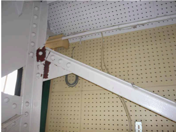
写真 7.4-3 ステージ側 X 形筋かい接合部の損傷(未補修)
