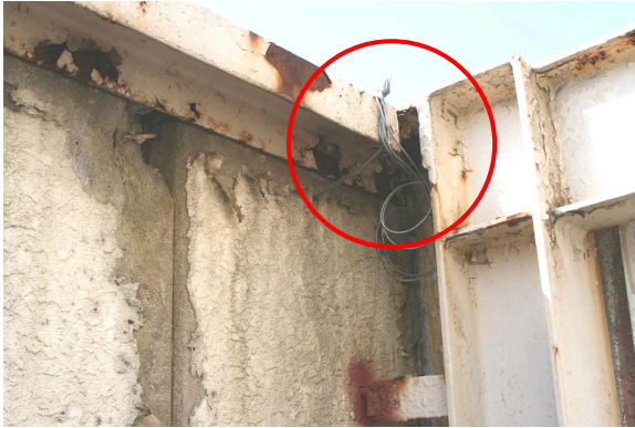
写真 7.2-4 応急処置をしたまま放置されている外階段の ALC 板
