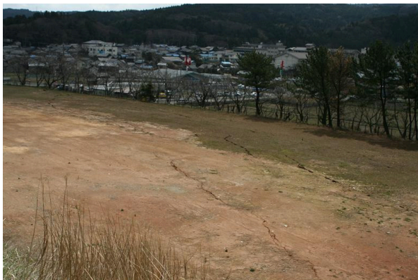
写真 22-3 校庭にできた地割れ
