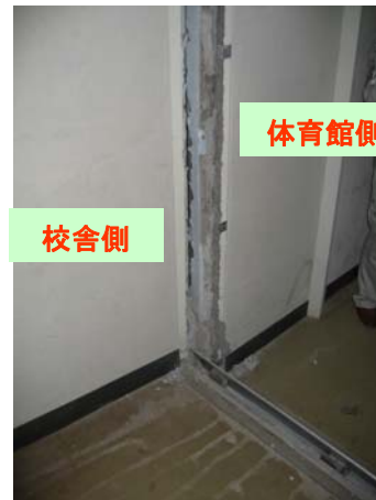
写真 2.2-2 体育館と校舎棟渡り廊下の Exp. J の損傷 (高浜小学校)
