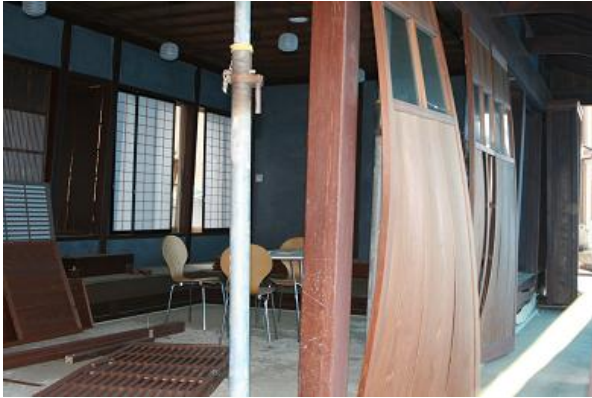
写真 4.1-11 建具の破損事例（門前地区）
