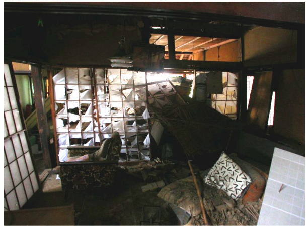
写真 4.5-2 上の住宅内部、地震時の変形により、障子が破れた様子が見える。
