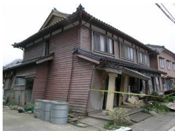
写真 4.1-3 柱の損壊事例1 (道下地区)
