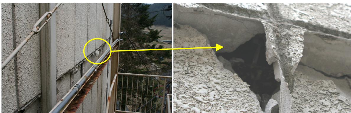
写真 3.4-2 脱落しそうになった外壁の ALC 板
