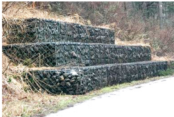
写真 7.1-3 玉石と鋼製ネットの斜面補強 （柏崎市軽井川）
