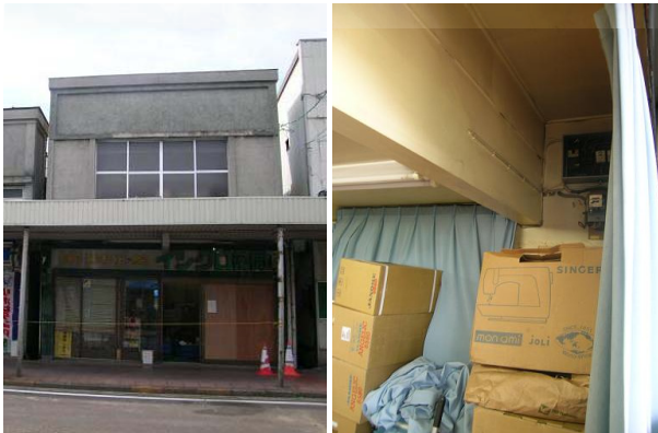
写真 4.8-3, 4 軽微な被害の木造商店(東本町)
