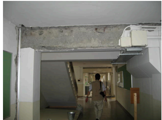
(d)仕上げモルタルの剥落
