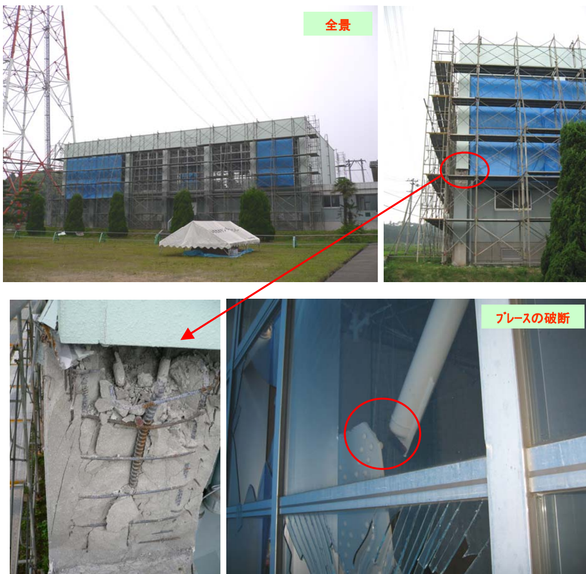
写真 2.2-3 上部鉄骨柱ベース部分のアンカーボルトの損傷とブレースの破断（勝山地区集会場）
