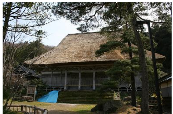
写真 6.2-6 阿岸本誓寺本堂(県指定)の被害
