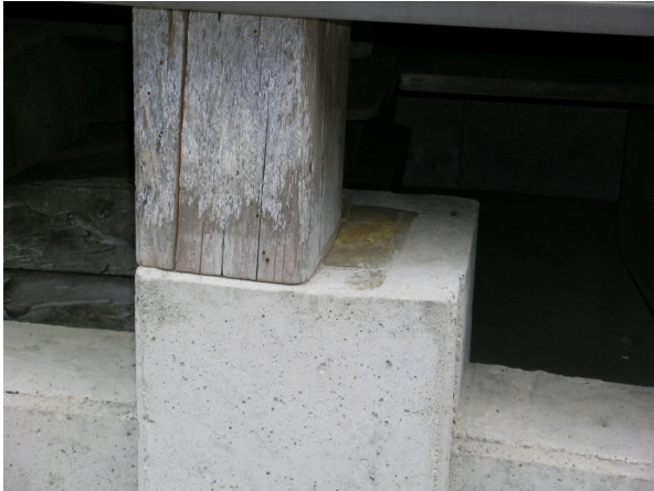
写真 6.2-8 法性寺本堂床下の状況
