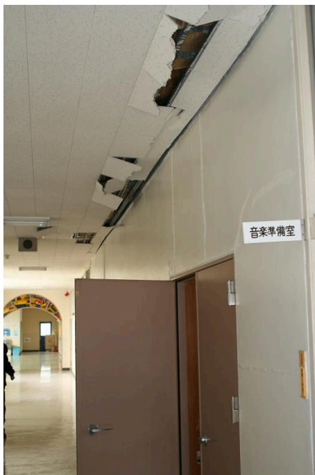
写真 22-1 ブロック張壁の面外方向揺れにより損傷した天井仕上げ材
