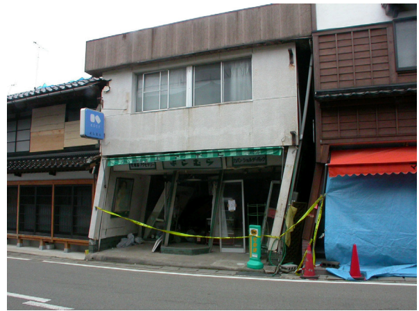
写真 4.2-1 門前地区の商店の被害例
