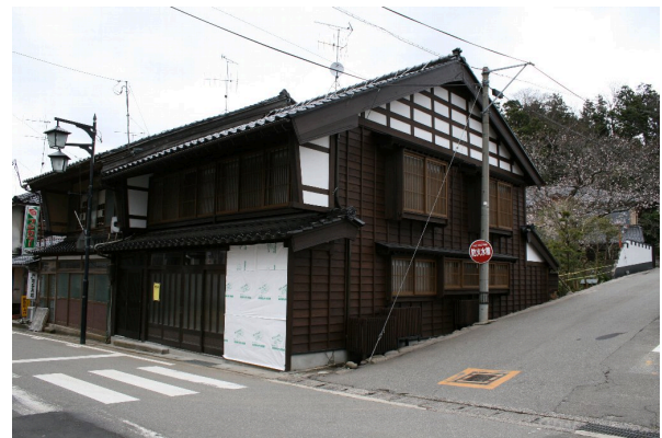
写真 4.2-2 門前地区の木造住宅は、一見被害が少ないように見えるが、内部は大きな被害を受けている。
