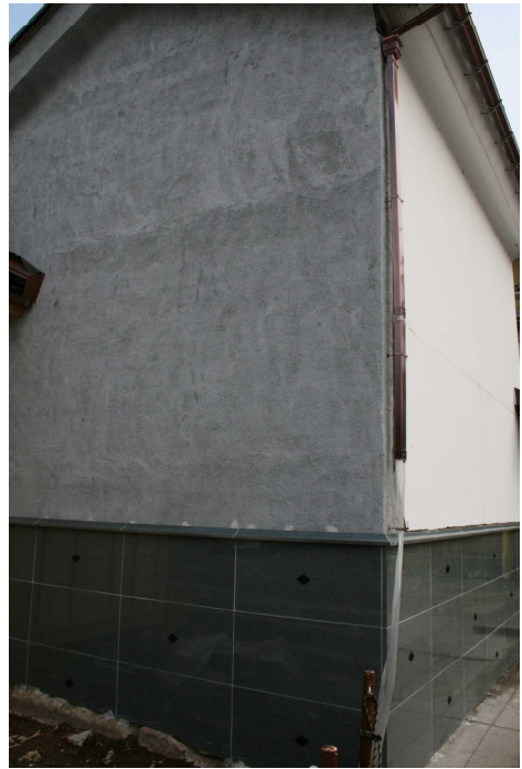
写真 7.6-3 モルタルと石張りで修復中の土蔵
