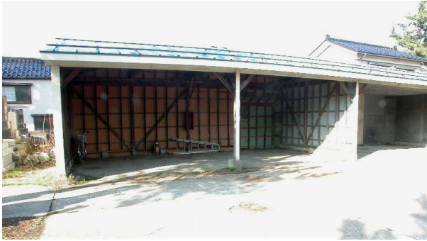
写真 4.8-2 方杖や筋かいが十分に配置された車庫
