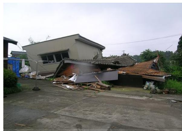
写真 4.3-1 圧壊した建物(柏崎市中田)
