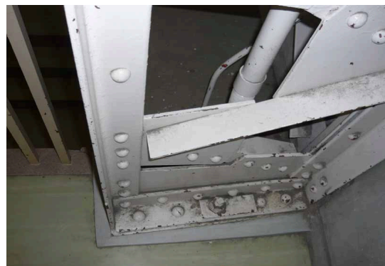
写真 7.4-2 ラチス柱脚部のねじれ(未補修)
