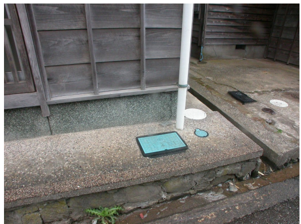
写真 4.2-7 黒島地区の住宅の基礎部分の損壊 このようにモルタルを塗ってあると、ひび割れた部分から水が入って、内部で柱や土台が腐朽していてもわからない。
