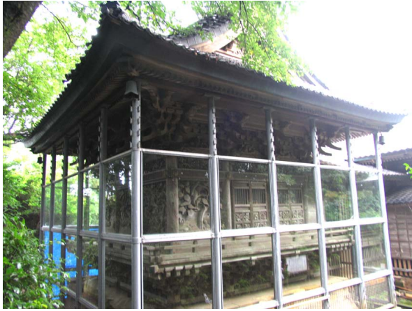
写真 6. 2-10 番神堂本殿の彫刻保護用支柱
