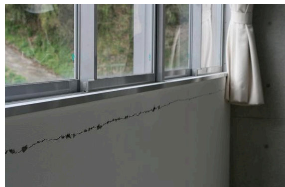
写真 3.3-5 窓枠取り付け部目地の開き
