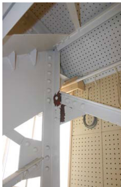
写真 2.1-2 柱外フランジの損傷
