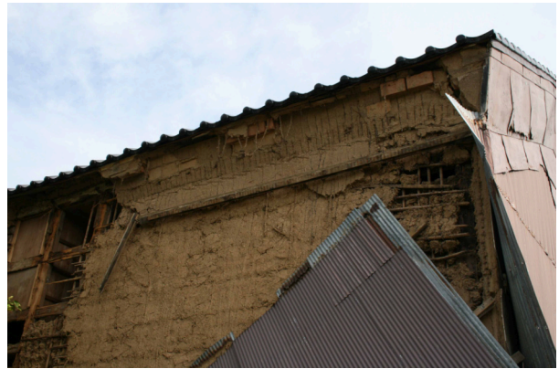
写真 5.2-2 軒瓦の下に煉瓦が縄で吊り下げてある。既に老朽化が進んでいた。
