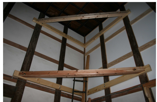
写真 7.3-4 焔魔堂、内部隅角部の補強
