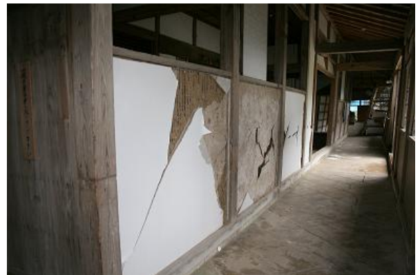
写真 6.4-1,2 総持寺僧堂の被害
